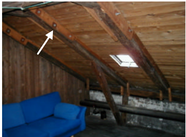
Tagkonstruktion: Forstærkning af spærsamlinger
